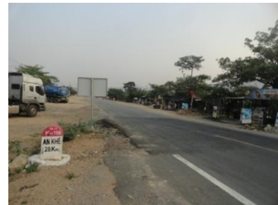
Hình ảnh trước khi nâng cấp tuyến đường QL 19 bổ sung
